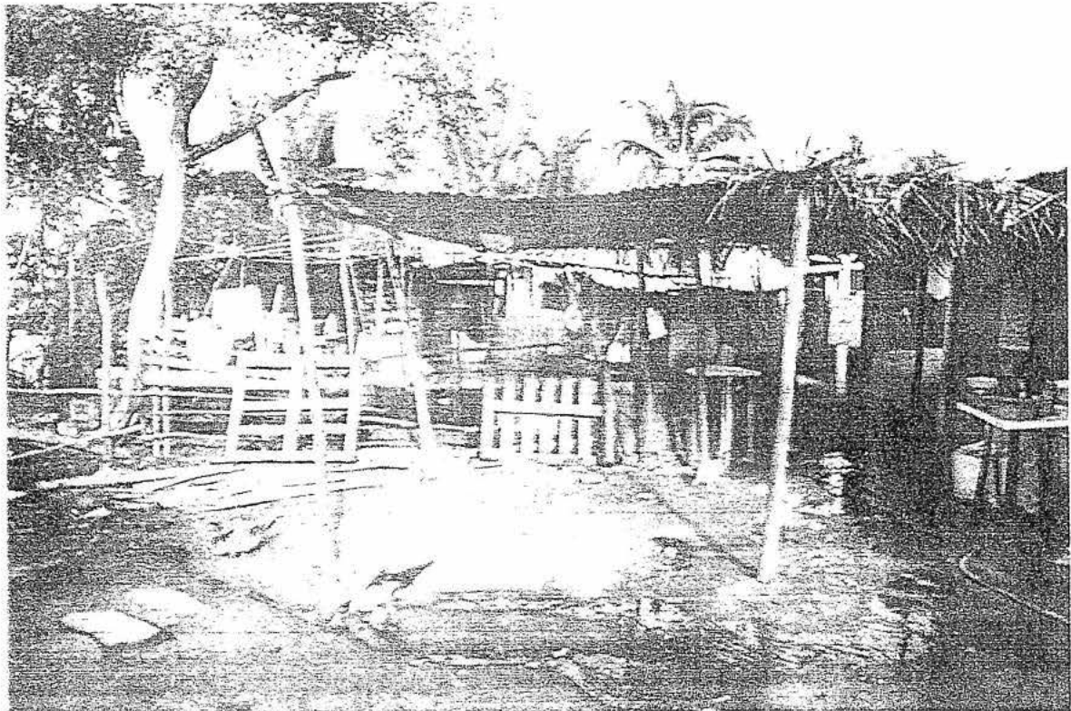
Figura 50.- Viviendas en Aquiles Serdán que requieren de reubicación
