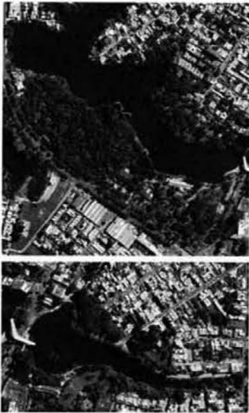
Figura 69. A la izquierda se observa el vaso Cerzalli y en la parte superior de la fotografía el MUSEO. A la derecha se observa parte del cuerpo líquido de las inundaciones y a la izquierda de este el área del parque. Tiene Guadalupe Ciudad, el Museo de Historia Natural, el Parque Museo La Venta, el Museo de Historia Natural, el Parque Delfos Abuelos y el parque Cuahitlán entre otros (Figura 69).
